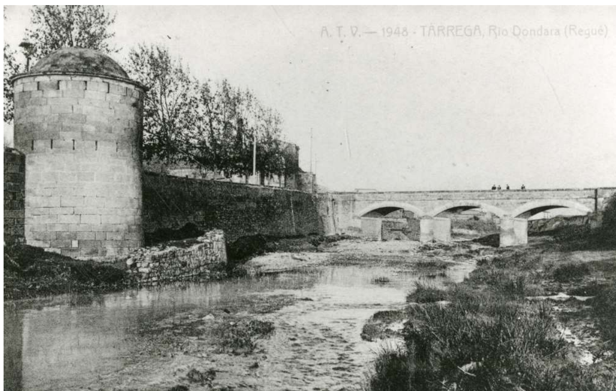
Fotos generales y de detalle de los torreones de Sant Eloi con las cubiertas conservadas a principios del siglo XX donde se puede apreciar la forma de la cubierta ligeramente abovedada.
